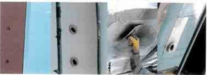
Abb. 4: Einbauschritte von Mauerziegel-Einbausteinen in die Wärmedämmung
